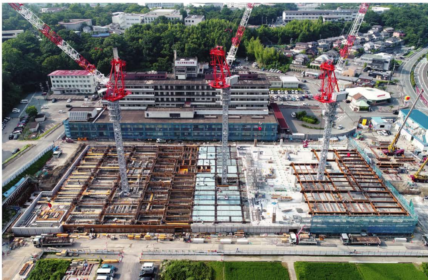
新病院建設工事現場（7月3日 撮影）
